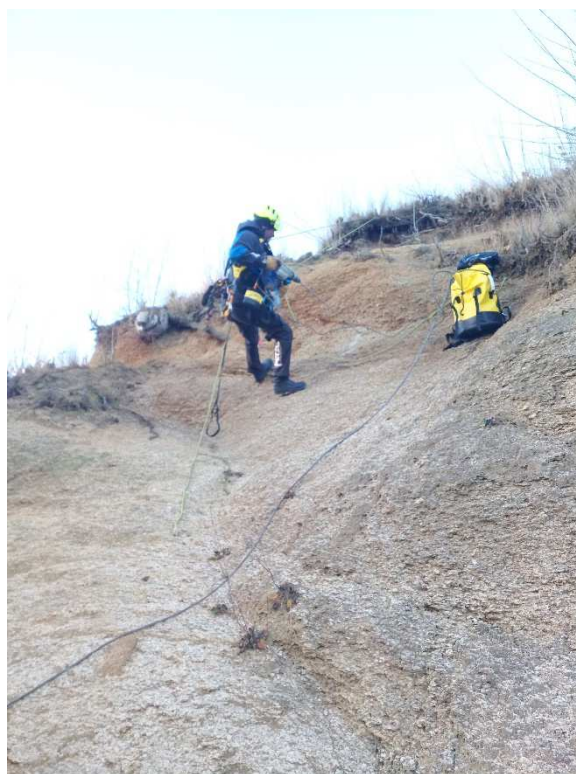
Foto 4: Realizace nejádrového vrtu ozn. D1.
