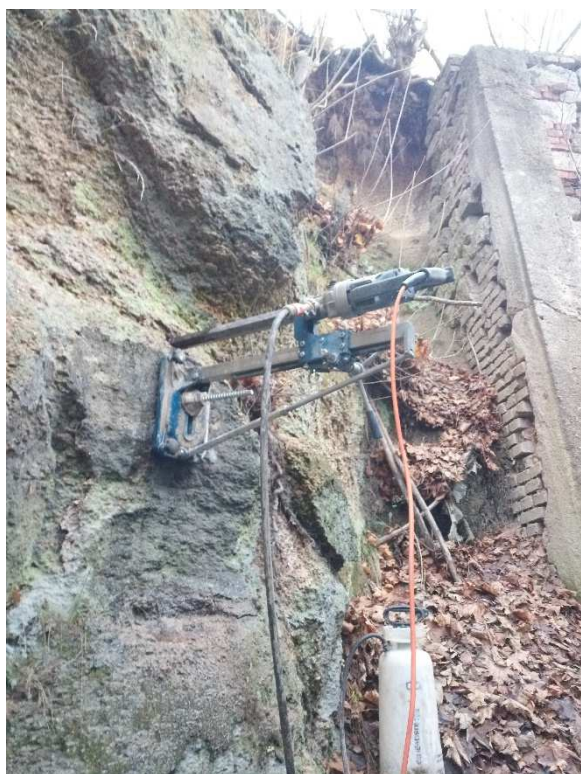
Foto 3: Realizace DIA jádrového vrtu ozn. V3.
