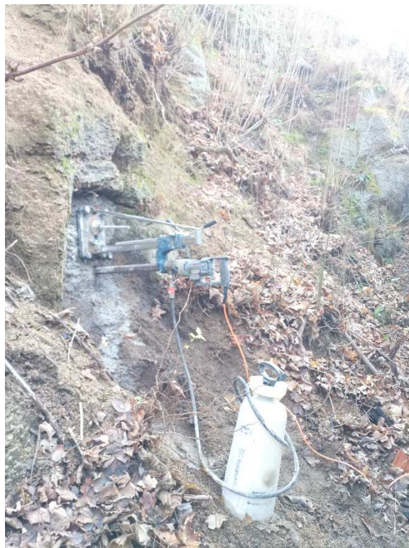
Foto 2: Realizace DIA jádrového vrtu ozn. V2.
